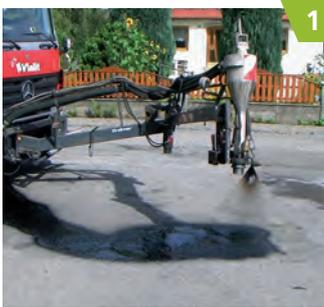
1 Druckluftreinigung und Einbringen von hochwertigem Bindemittel zur optimalen Haftung des Mischgutes.
