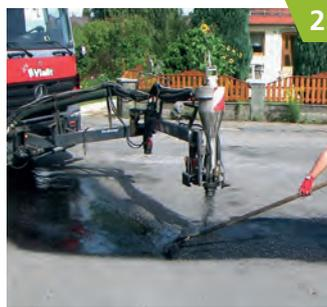
2 Überhöhte Aufbringung des **REPHALT®**-Mischgutes, welches innerhalb kürzester Zeit aushärtet.
