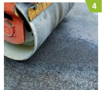
4 Nach dem Abstreuen mit Splitt erfolgt eine abschließende Verdichtung mit einer Glattmantel- oder Kombiwalze.
