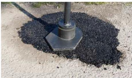
Zur fachgerechten und manuellen Verdichtung von **REPHALT®** und **OECOPHALT® KMG** bei Kleinflächensanierung. Gelenkschonend durch Gummipuffer.
